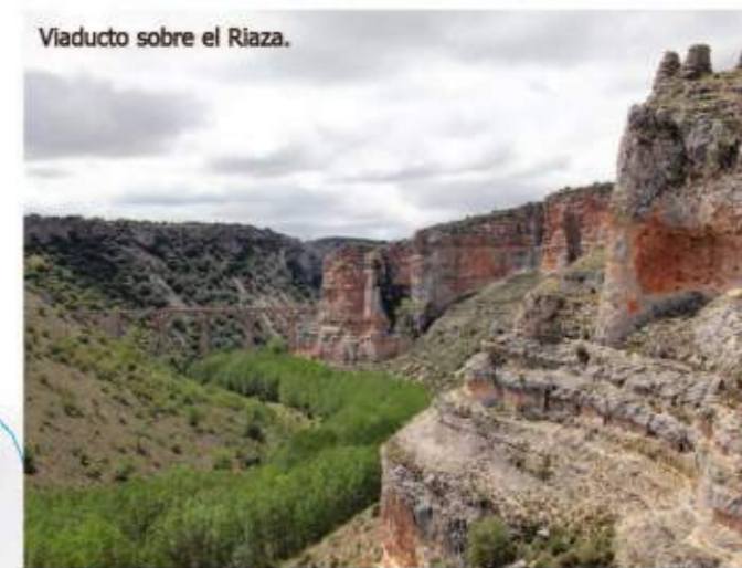
Viaducto sobre el Riáza.
