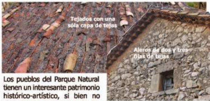
Tejados con una sola capa de tejas
